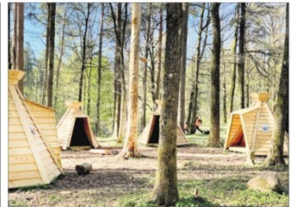
MER KOMMER: Tipplyttene bygd og gapahuger er bygd, nå gjenstår bare bilplasser og kløtrestengelen. Alt skal være ferdig før sommeren.
